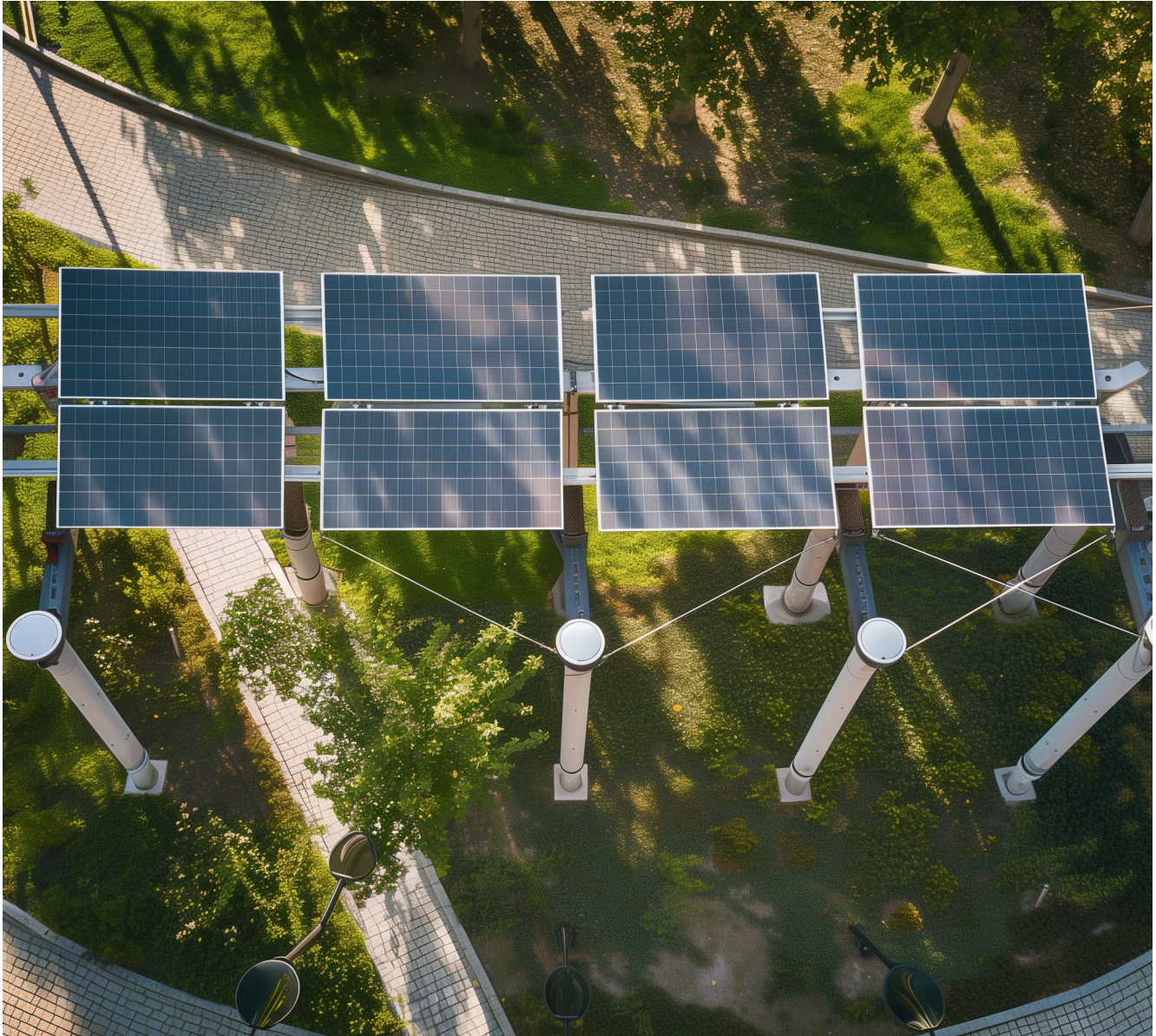
Abb. 2: Solarmodule in einem öffentlichen Park. Generiert mit Midjourney AI.
