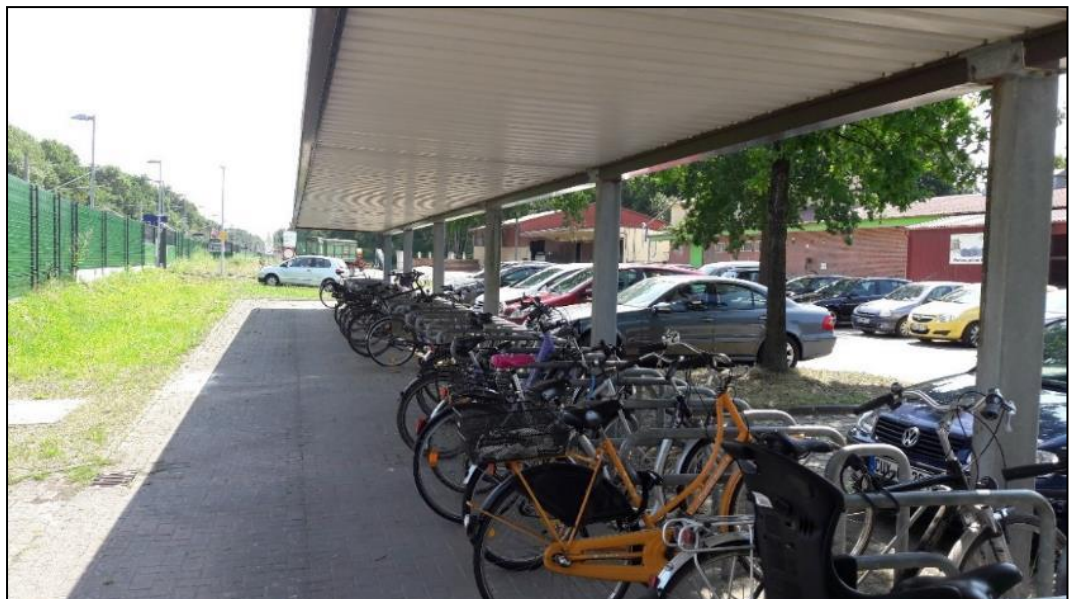
Abbildung 30: Vorhandene Fahrradunterstell- und Parkplätze am Bahnhof in Lübbestedt
