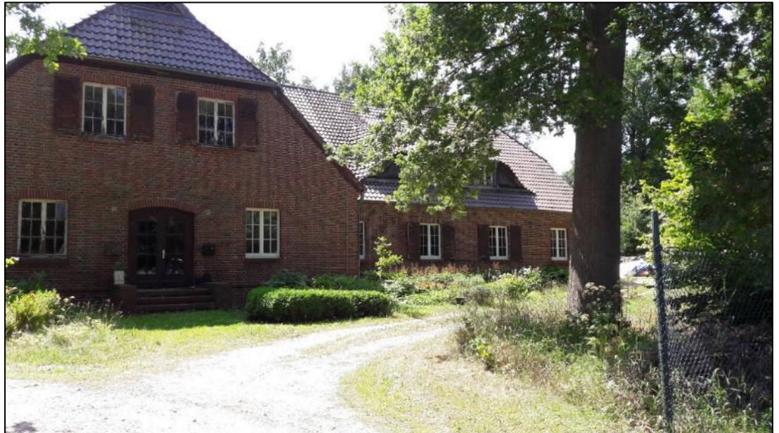
Abbildung 39: Ehemaliges Offiziersgebäude der MUNA-Lübberstedt
